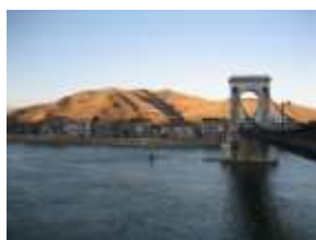
Tain l'Hermitage im Februar
